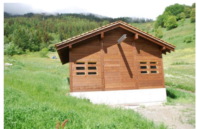
Vue de la petite centrale
