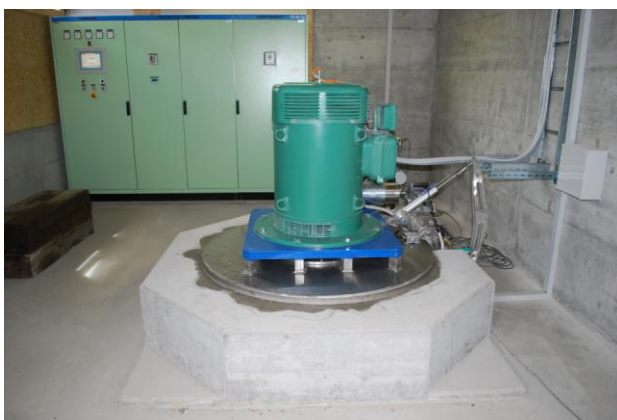
Petite turbine Pelton à 1 injecteur
